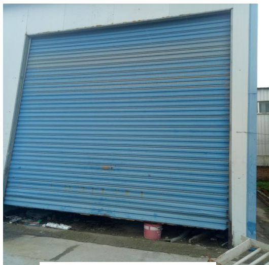
危废暂存间图片
